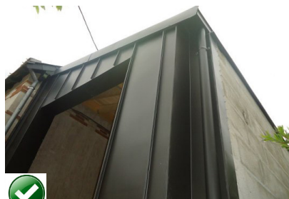
Bonne pratique : Descente d'eau pluviale intégrée
