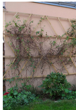
Bonne pratique : Murs sains et systèmes porteurs appropriés en retrait des façades.
