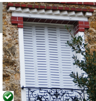
TRAVAUX INADAPTÉS : Coffre de volet saillant en façade et coloré dans une teinte différente des fenêtres.
