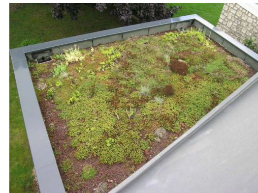
Toiture végétalisée de type extensif.
