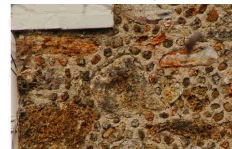
Parement de pierres meulières et rocaillage des joints
