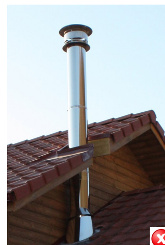
BONNE PRATIQUE : Positionner le conduit au plus près du faitage pour limiter la hauteur de conduit
