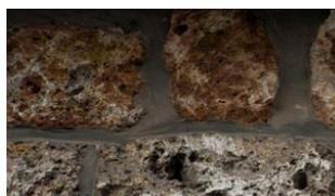
Parement de pierres meulières
