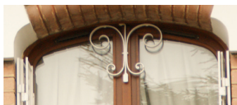
BONNE PRATIQUE : Adapter la menuiserie à la forme de la baie
