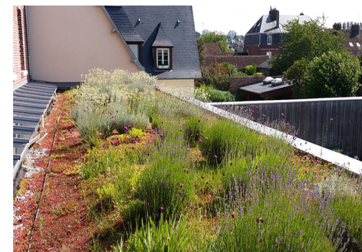
Toiture végétalisée de type intensif.
