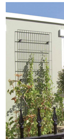
Bonne pratique : Murs sains et systèmes porteurs appropriés en retrait des façades.
