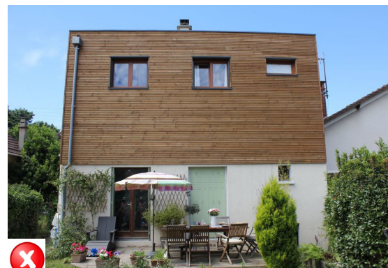
Mauvaise pratique : Mauvaise proportion des fenêtres ajoutées. Déséquilibre entre plein et vide.
