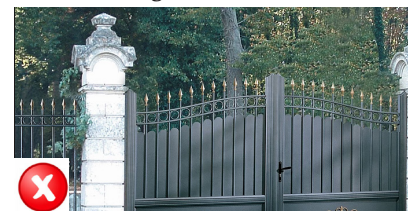
Mauvaise pratique : Peinture dorée sur les flèches de ferronnerie.
