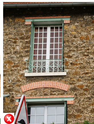
TRAVAUX INADAPTÉS : L'usage et la taille des petits carreaux doivent être cohérents avec l'époque et le style du bâtiment. Les tous petits carreaux du haut sont plutôt représentatifs d'un bâti du XVIIème s. et antérieur. Les carreaux du bas présentent des proportions carrées. Il n'est pas recommandé de multiplier les proportions très variées sur une même façade.
