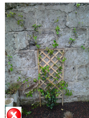
Mauvaise pratique : Végétalisation sans structure porteuse sur un mur présentant des pathologies.
