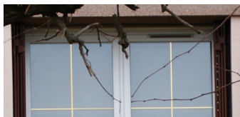
TRAVAUX INADAPTÉS : L'usage de laiton en remplacement de petits bois, non traditionnel dans le bâti ancien, n'est pas recommandé.
