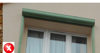
TRAVAUX INADAPTÉS : Coffre de volet saillant en façade et coloré dans une teinte différente des fenêtres.
