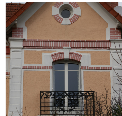
Façade enduite avec un enduit coloré
