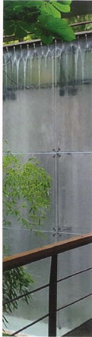
MUR D'EAU SUR LES FAÇADES DE L'ACCÈS À L'ÉCOLE DE MUSIQUE
