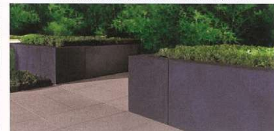
MURET DE RÉTENTION DES TERRES SUR TERRASSES PRIVÉES
