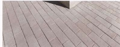
PAVÉS BÉTON PERMÉABLES SUR L'ENSEMBLE DES ALLÉES
